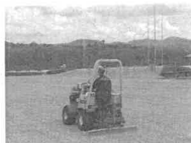
【目砂擦り込み作業】
