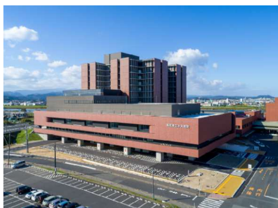
※新病院完成写真
