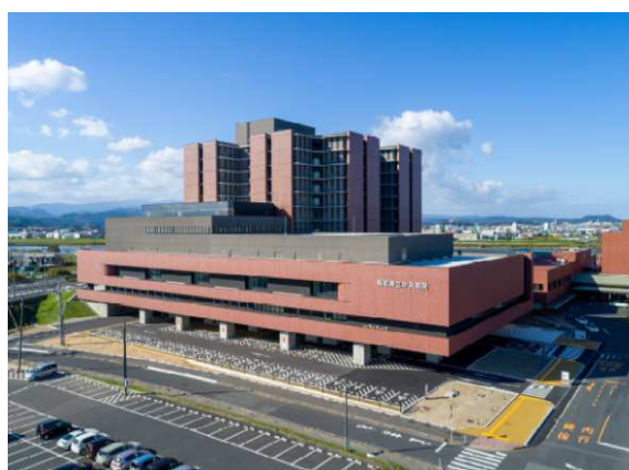
※新病院完成写真
