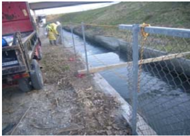
金網フェンスの 設置
