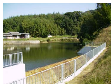
金網フェンスの設置状況
