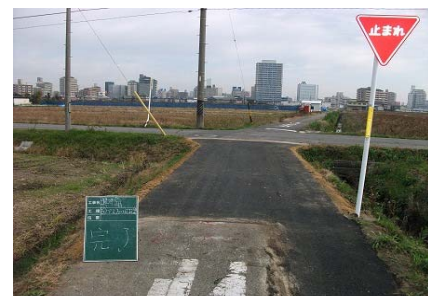
アスファルト舗装の打換え
