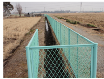
新たに設置された 金網フェンス
