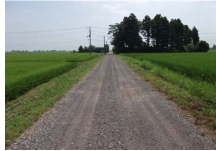
未舗装農道（砂利の路面）
