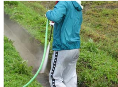
高圧洗浄機による 水路内の清掃
