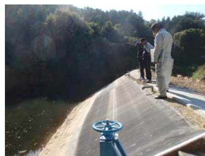
遮水シートの設置
