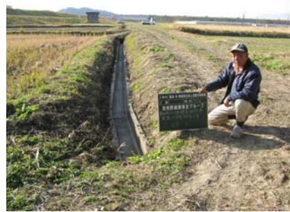
土側溝をコンクリート側溝に更新
