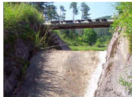
洪水吐の補修
