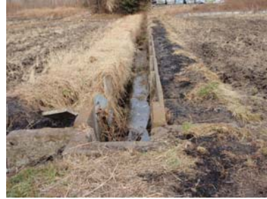
老朽化した水路（全景）
