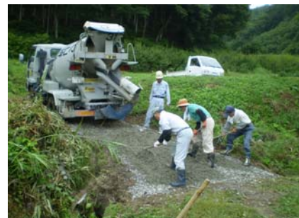
コンクリート舗装状況
