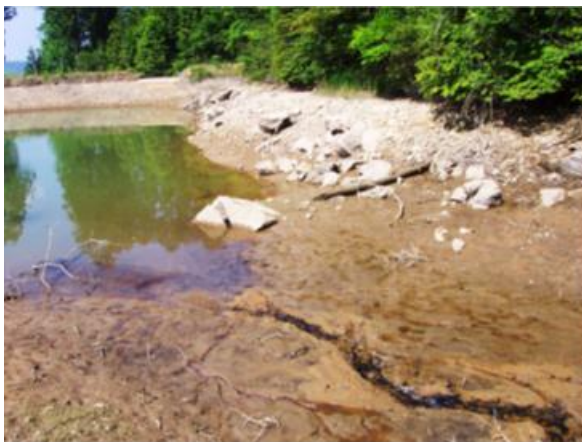
ため池に流入した土砂
