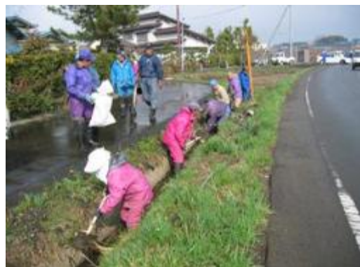
側溝の泥上げ
