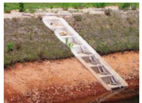
斜樋と取水栓（コンクリート製品）
