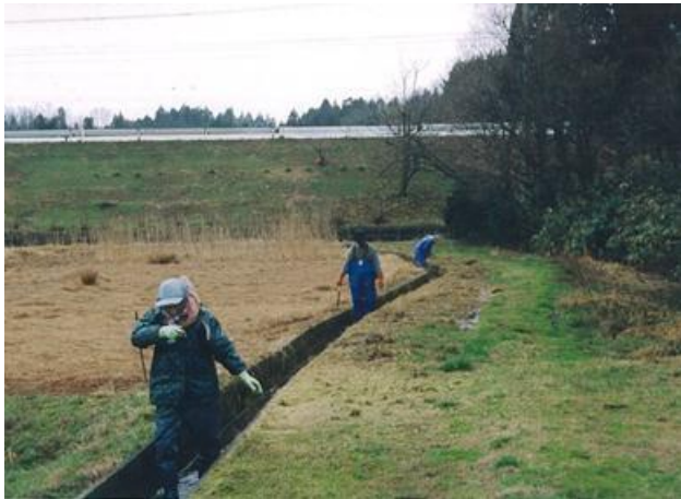
開水路における機能診断の実施状況
