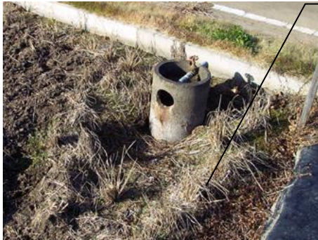
(ファームポンド等) 調整施設に損傷がないか
