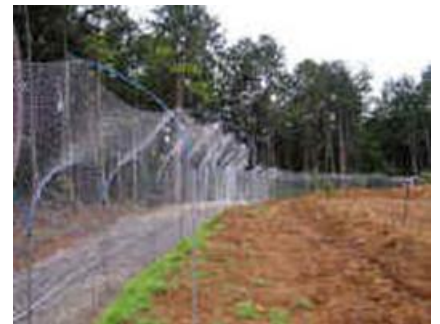
防護柵設置状況
