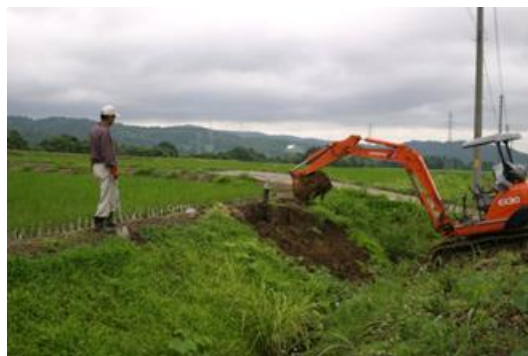
農用地法面の補修
