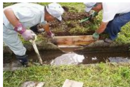
U字溝の改修作業
