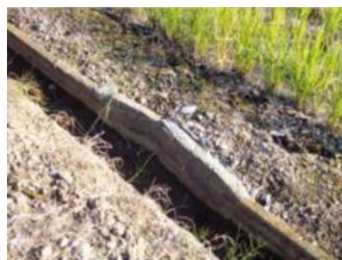
改修したU字溝
