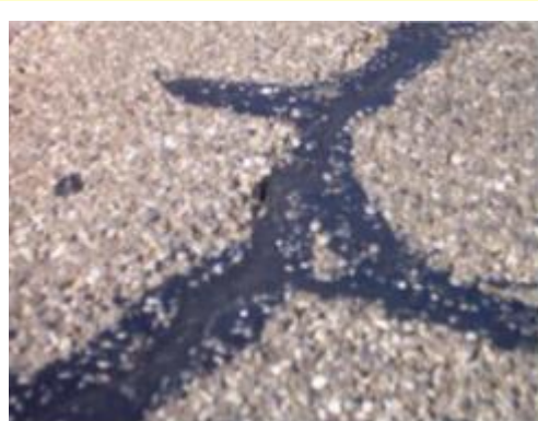
ひび割れの補修 (路面) (アスファルト乳剤系補修材による補修)
