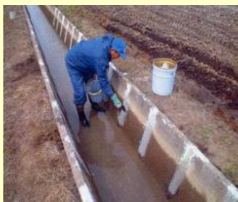
目地詰め作業
