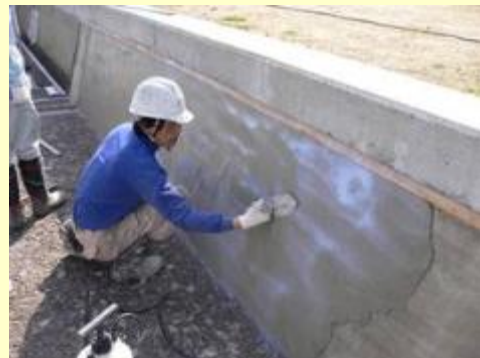
コーティング作業の状況
