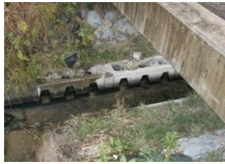
多孔コンクリート護岸
