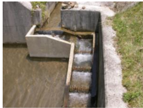
段差解消水路
