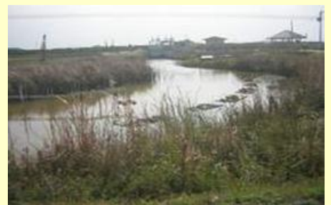
浄化池の状況
