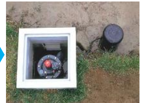
給水栓の自動化へ改良
