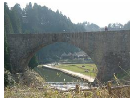
逆サイホンを利用した水路橋で国の重要文化財にも指定されている通潤橋 (熊本県山都町)
