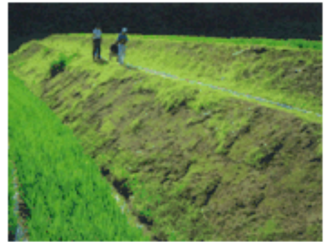
小段（犬走り）設置後の法面
