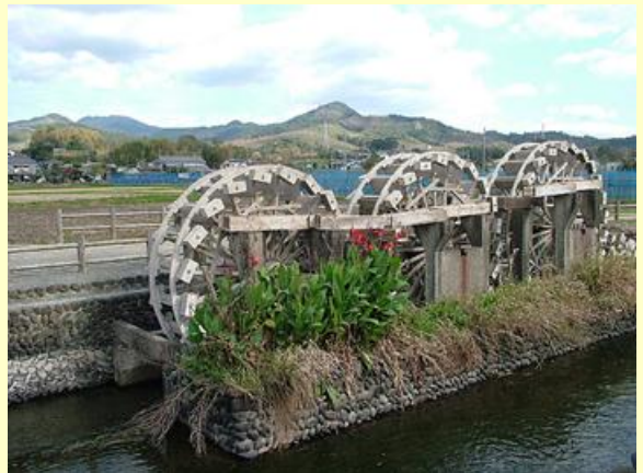
国指定史跡の 「堀川用水及び朝倉揚水車」
