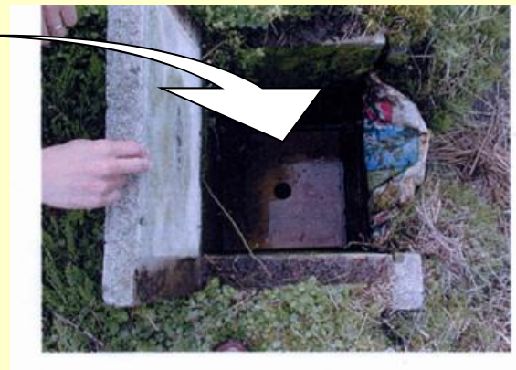
排水調整板設置状況
