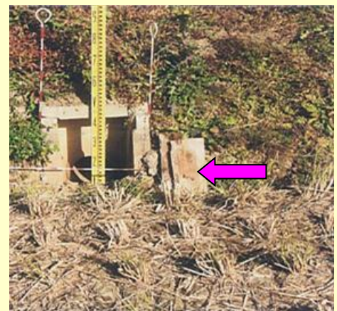
排水調整板設置状況
