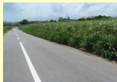
グリーンベルト設置
