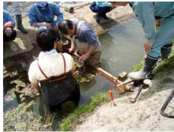
魚道の設置状況（堰板の設置）
