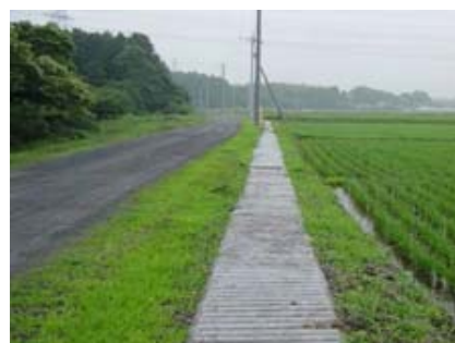
水路へのコンクリート蓋の設置
