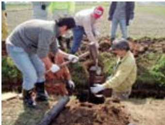
魚道の設置状況
