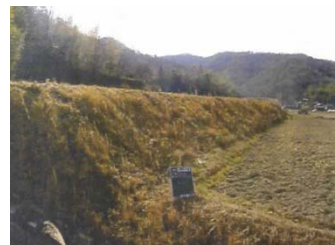
高低差のある畦畔法面
