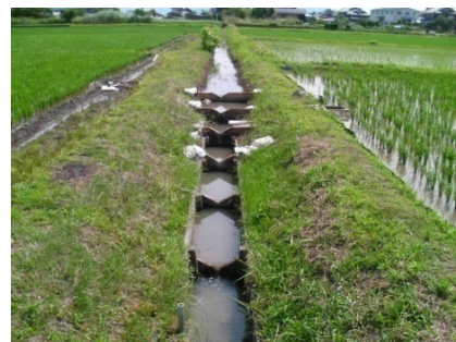
水路魚道（排水路堰上施設）
