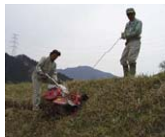
小段設置状況（掘削）
