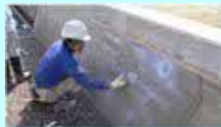
老朽化した水路壁のコーティング
