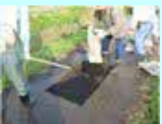
農道の部分補修
