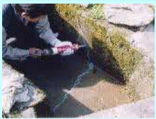
水路のひび割れ補修
