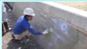
老朽化した水路壁のコーティング
