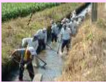
水路の泥上げ
