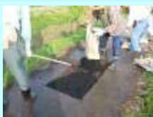
農道の部分補修
