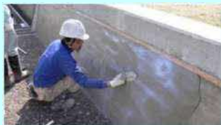
老朽化した水路壁のコーティング
