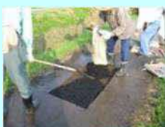
農道の部分補修
