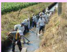
水路の泥上げ
