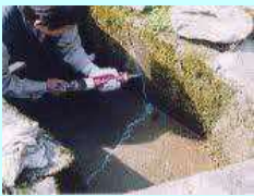
水路のひび割れ補修
