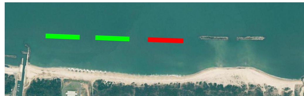
④両三柳工区 沖合施設 1基目(9月～)
