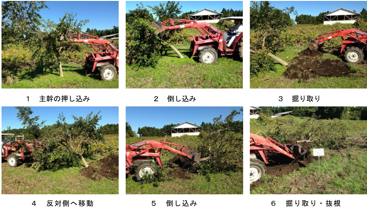
図1 フロントローダによる抜根作業手順
