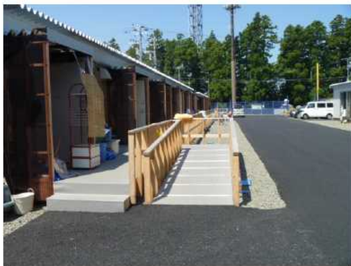
事例3: 住戸前の舗装、スロープの設置
