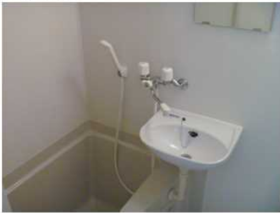
事例1:浴室のシャワー取り付け
