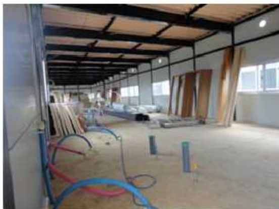
鉄骨造(組み立て式)
