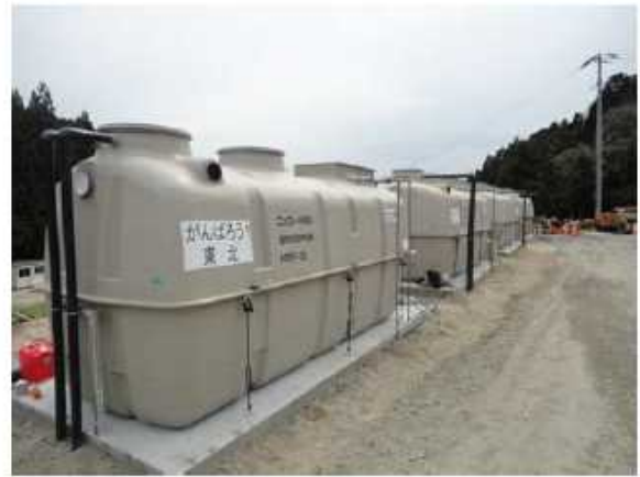
事例2:浄化槽の設置
