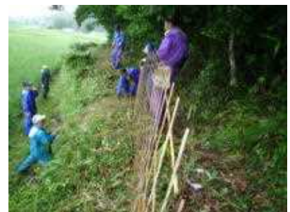
イノシン柵の共同設置作業
