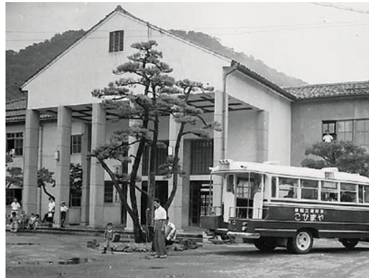
昭和19年建築の庁舎（3代目）
